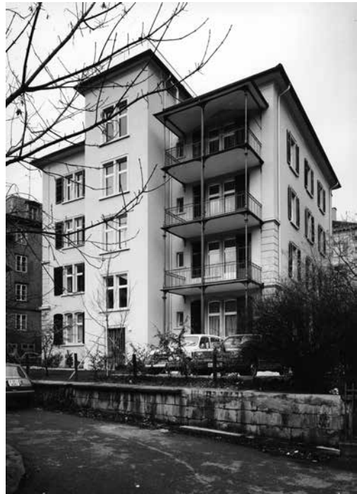
Abb. 8: Hinterseite der Plattenstrasse 32, wo sich der Gebäudeeingang sowie der Balkon der Cafeteria im zweiten Stock befanden (1975). Archiv Universität Zürich.
